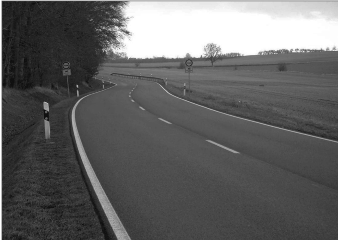
Einbahnig zweistreifige Landstraße mit Regelquerschnitt RQ 11 der EKL 3 (Foto: Lippold, TU Dresden)
