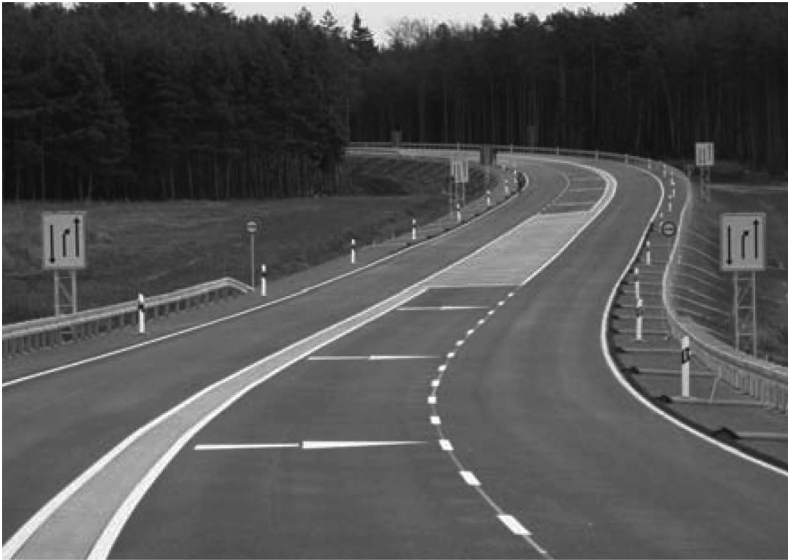
Durchgehend dreistreifiger Regelquerschnitt RQ 15,5 der EKL 1 (Foto: Weise, TU Dresden)
