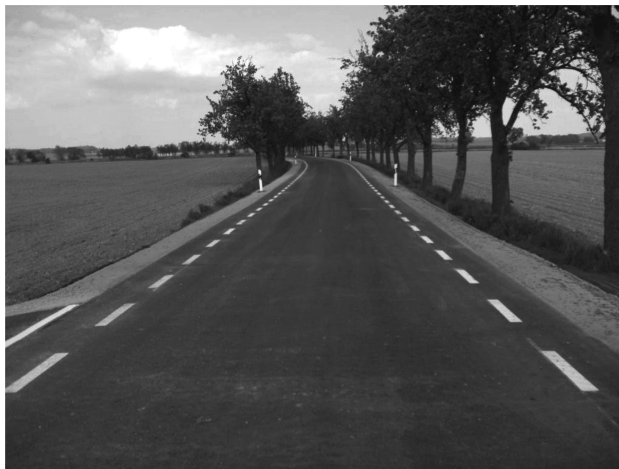
Einbahnige Landstraße mit Regelquerschnitt RQ 9 der EKL 4 (Foto: Lippold, TU Dresden)
