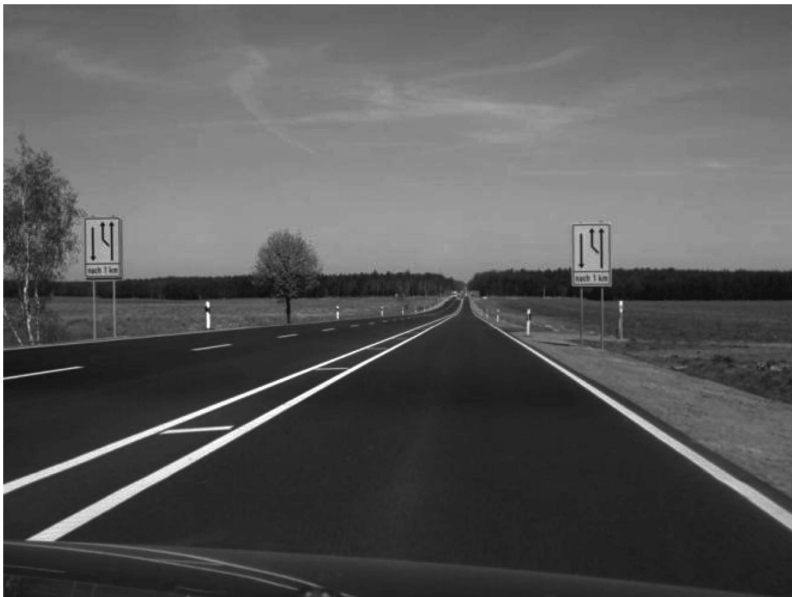
Abschnittsweise dreistreifiger Regelquerschnitt RQ 11+ der EKL 2 (Foto: Weise, TU Dresden)
